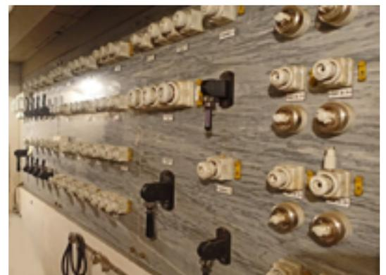
Bild 10: Dieses AEG-Stellwerk wurde in zwei verschiedenen Verwendungen eingesetzt, einmal als Stellwerk für drahtseilgeführte Helligkeitsregler (Rheostaten) und zum anderen als Stelleinheit für die damals üblichen Seilzuglaternen oder Farb- und Abdeckscheiben der Beleuchtung der Rundhorizontanlagen der Bauart AEG.
