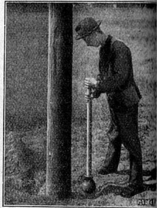
Abb. 145. Feststampfen des Mastes.
