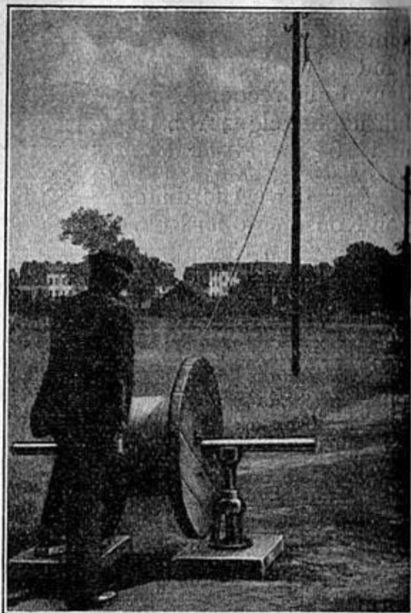
Abb. 156. K 1328 Drahttrommel auf Windeböcken; Bremsholz unter der linken Wange.
