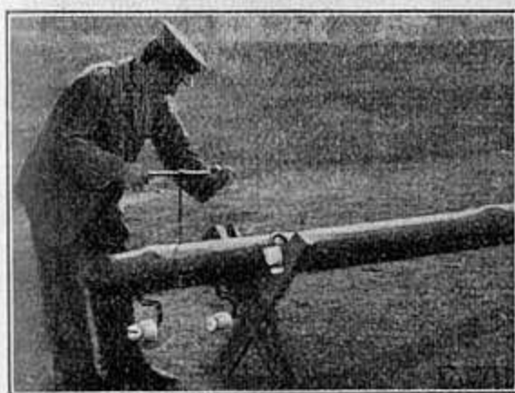
Abb. 141. K 1317 Einschrauben der Isolatoren in den liegenden Mast.
