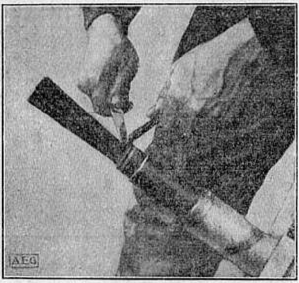
Abb. 98. K 1276 Abschneiden der Fülljute. Nicht gegen das Kabel schneiden.
