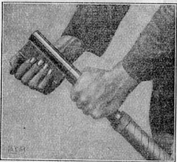
Abb. 96. K 1274 Abreißen des Bleimantels.
