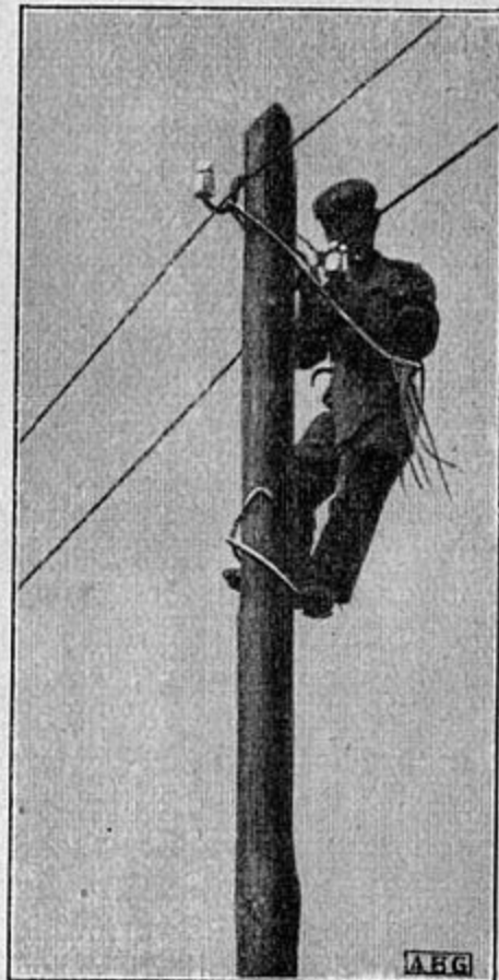
Abb. 166. K 1343 Abbinden der Leitung nach Besteigen des Mastes mittels Steigeisen.
