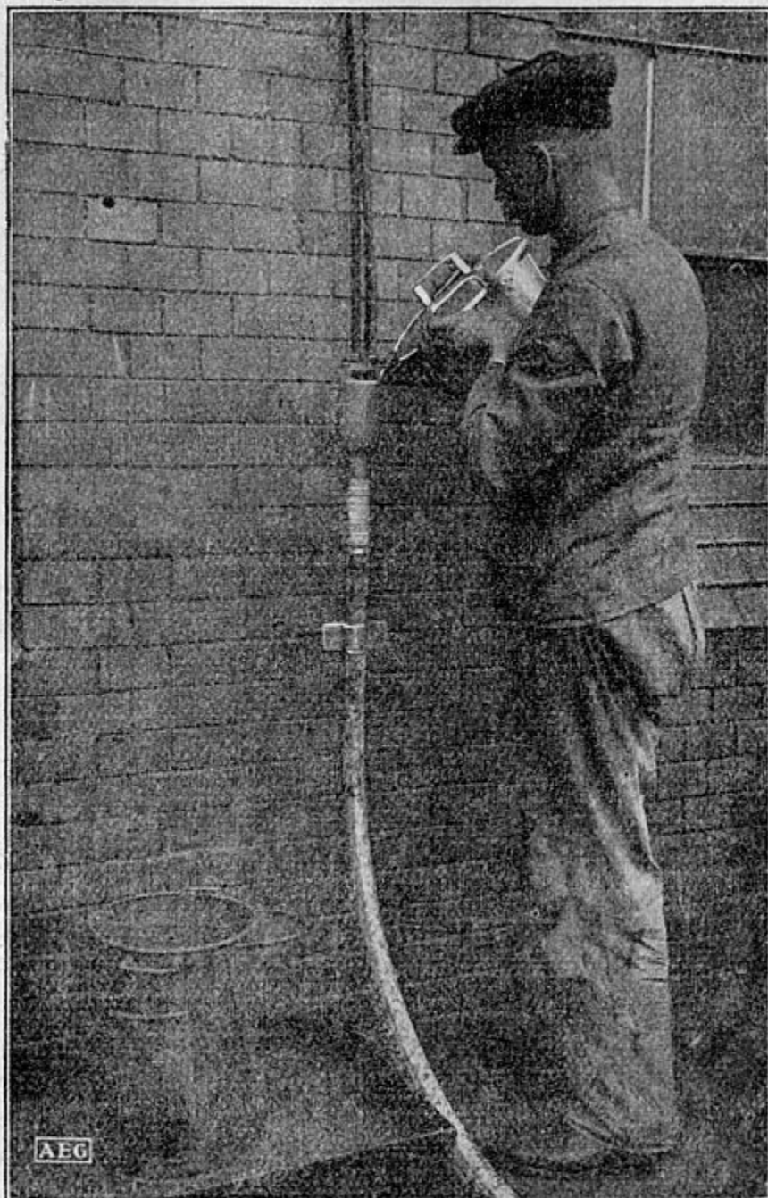
Abb. 102. Anwärmen der Vergußmasse auf einem Blechofen, welcher zur Verhütung der Feuersgefahr in einem Sandkasten steht. Vergießen eines Blechendverschlusses.
