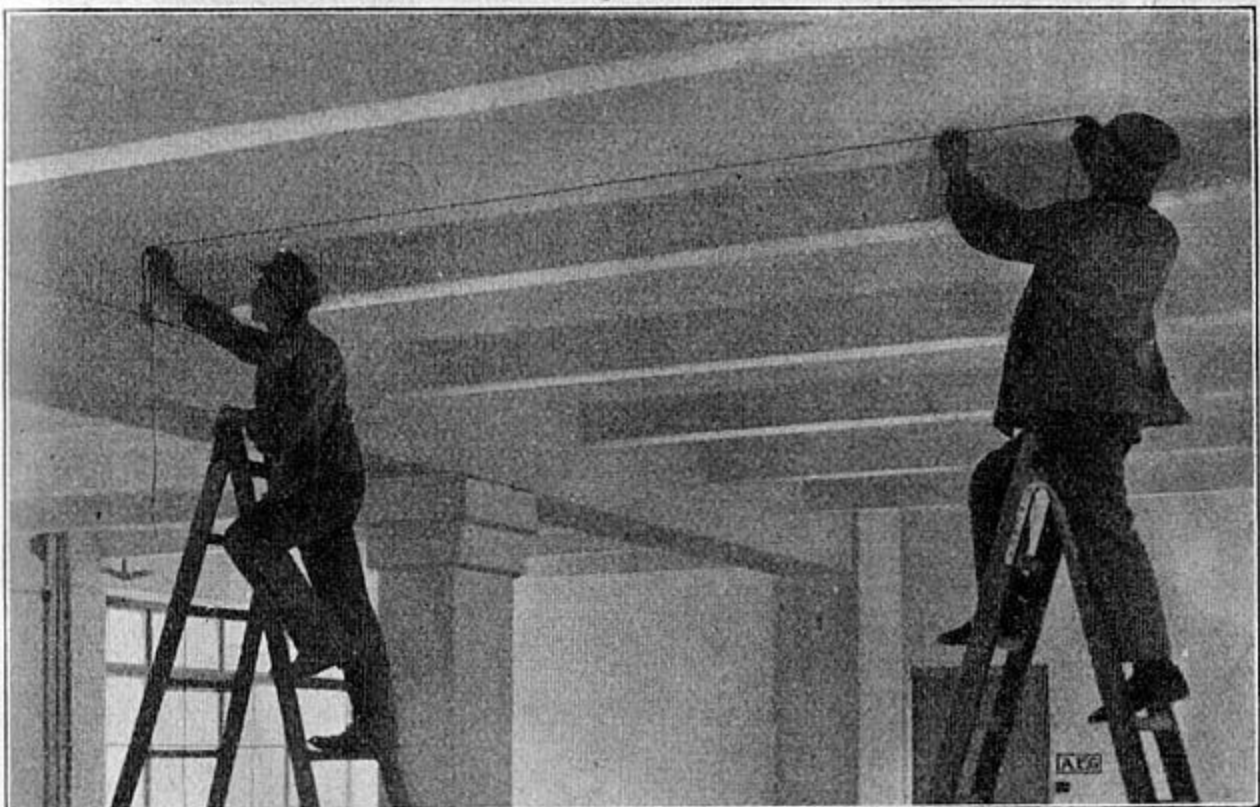
Abb. 9. Ein mit Kreide oder Kohle bestrichener Bindfaden wird gespannt und gezupft. (Vorzeichnen durch Schnurschlag.)
