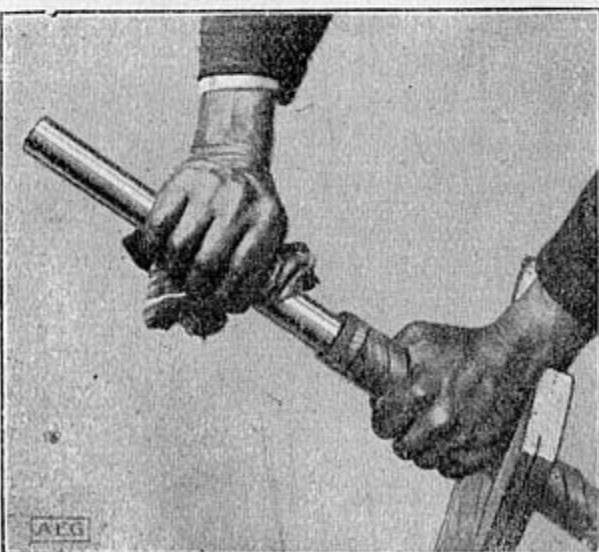
Abb. 94. 1272 Reinigen des Bleimantels mit Benzin.
