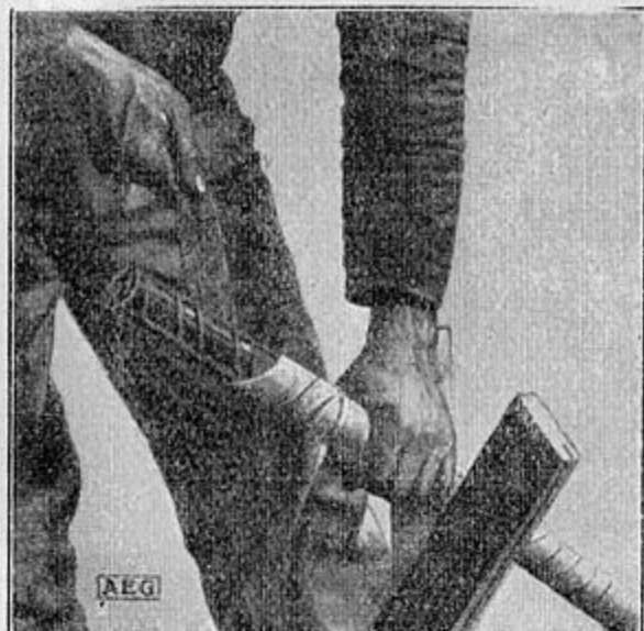
Abb. 91 K 1269 Entfernen der äußeren Jute.
