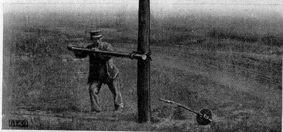
Abb. 144. Eindrehen eines Mastes in ein gebohrtes Loch.
