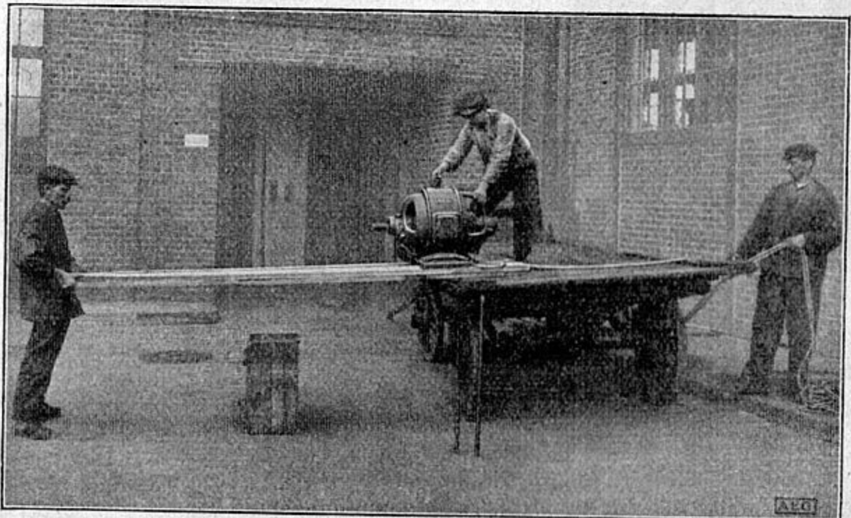
Abb. 49. Wenn der abzuladende Motor auf den Bohlen steht, werden diese unter Anspannen des Halteseiles nach unten gekippt.
