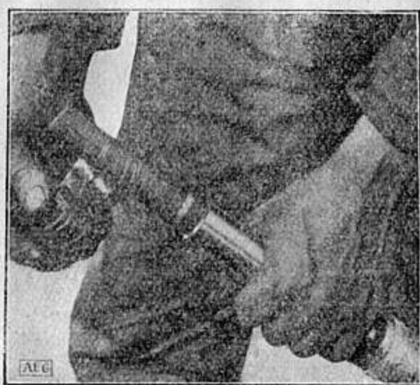
Abb. 97. K 1275 Abreißen der Papierisolation nach dem Abbinden.
