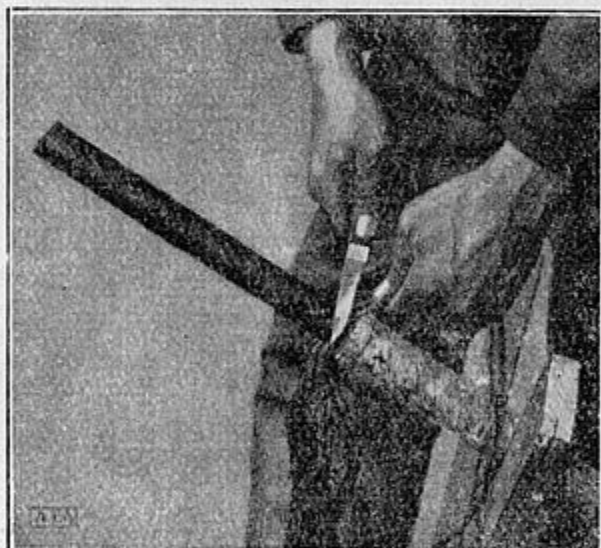
Abb. 93. Abschneiden der inneren Jute K 1271 Nicht gegen das Kabel zu schneiden.
