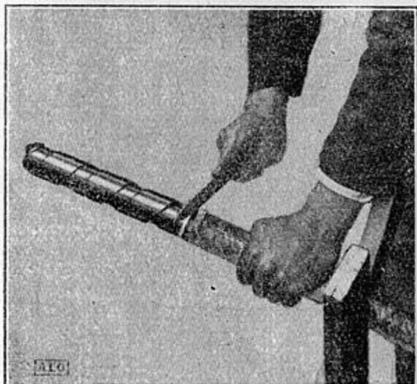
Abb. 92. K 1270 Durchfeilen des Eisenmantels.
