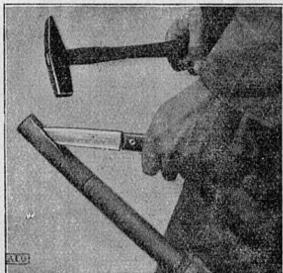
Abb. 95. Aufschneiden des Bleimantels. K 1273 Messer flach (tangential) zur inneren Isolierung.
