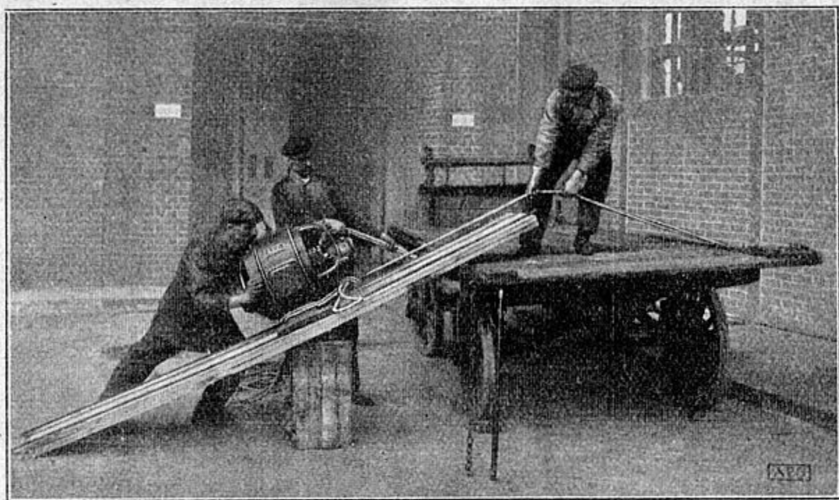
Abb. 47. Aufladen eines Motors. Ueber die Flacheisen auf den Bohlen gleitet K 1439 der Motor leicht nach oben, wenn der auf dem Wagen stehende Mann das Seil kräftig anzieht.
