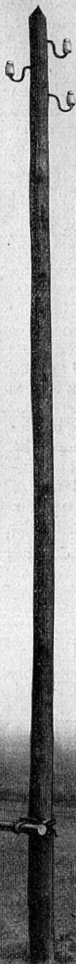
Abb. 144. Eindrehen eines Mastes in ein gebohrtes Loch.
