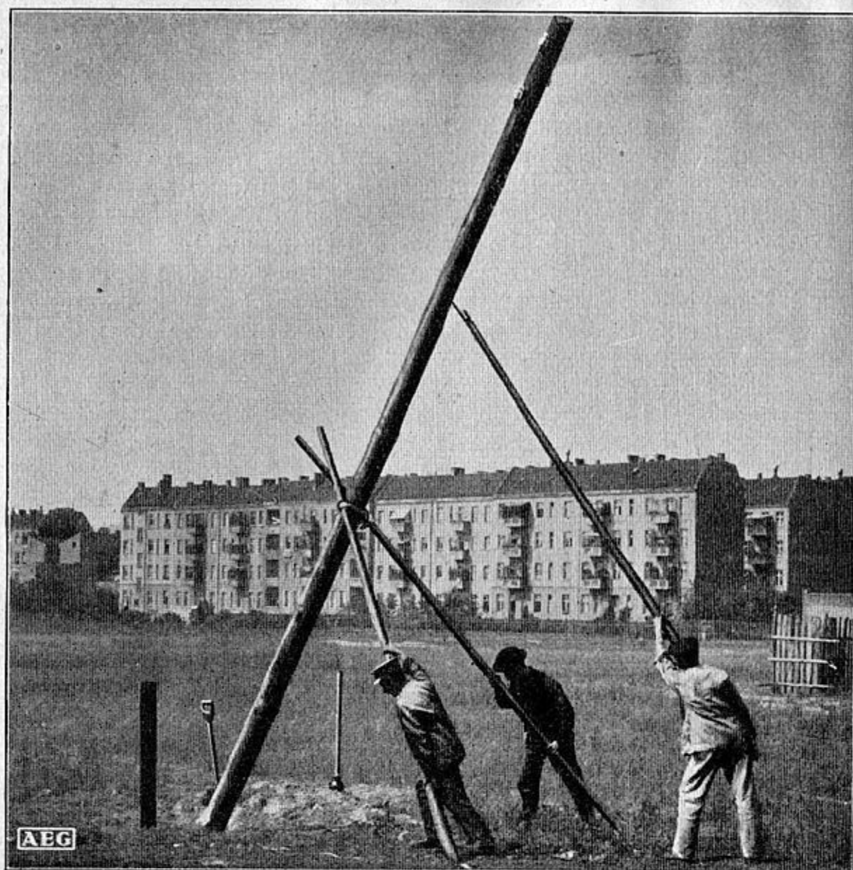
Abb. 142. Aufrichten des Mastes.
