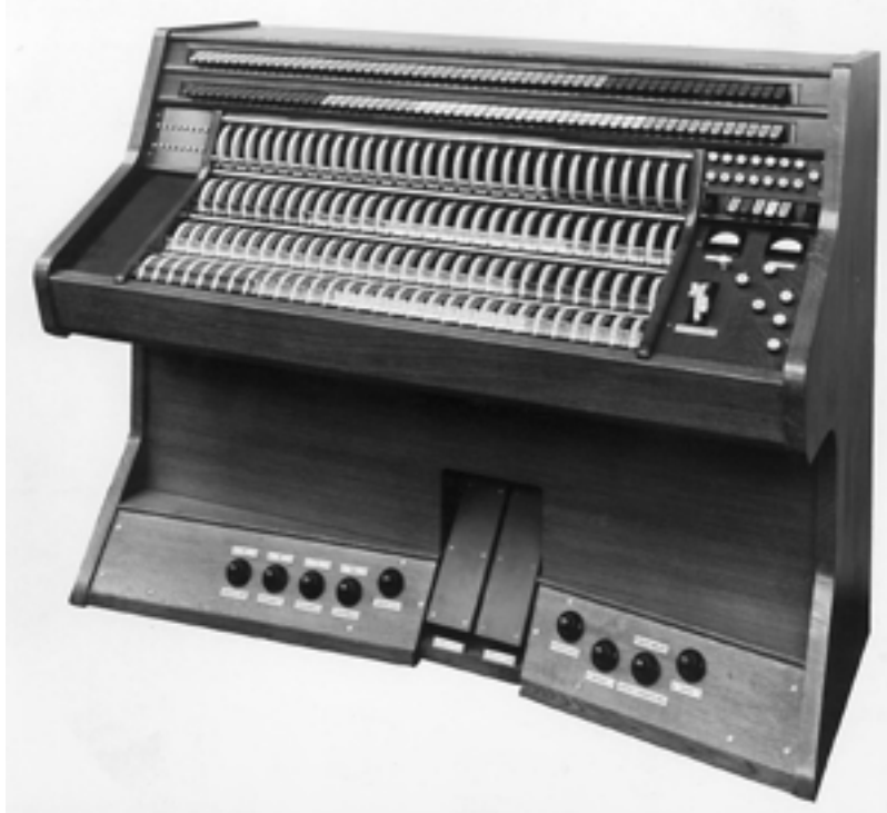
Strand system CD, two preset console, with clutch-driven resistance dimmers, Sadler's Wells, London 1960s Strangsystem CD, Konsole mit zwei Voreinstellungen, mit kupplungsgetriebenen Widerstandsdimmern, Sadler's Wells, London 1960er
