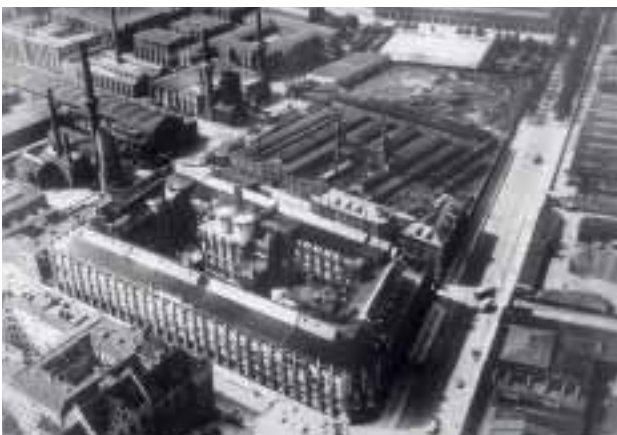
The lamp factory of the Allgemeine Elektricitäts-Gesellschaft (AEG) in Berlin Moabit, Sickingenstrasse.
